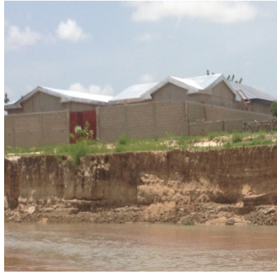
Fig. 3. Habitations à risque sur une berge menacée d'effondrement Source: auteur
