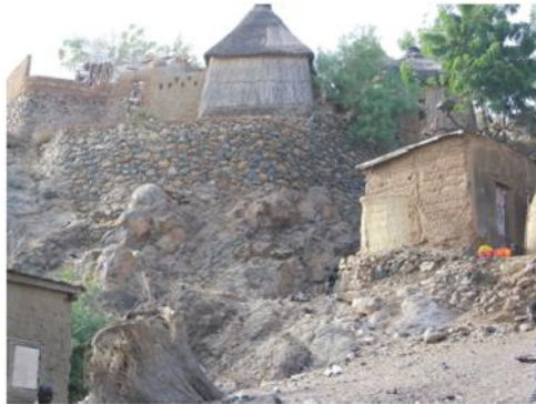
Fig. 2. Habitations vulnérables sur les flancs des montagnes (Zokok)
