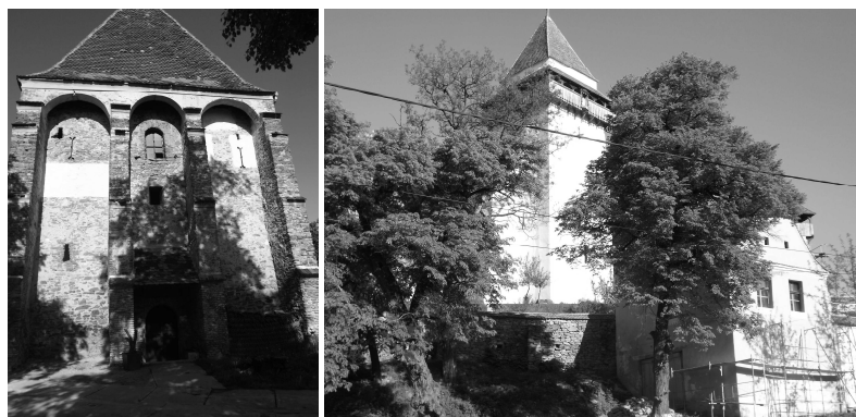
Fig. 5. L'église fortifiée d'Axente Sever – a) la façade ; b) les murs et les fortifications (photo Grecu, 2012)
