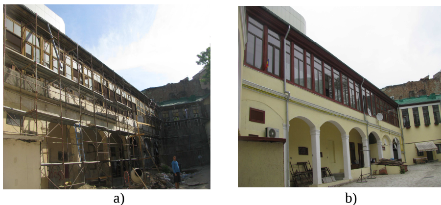
Fig. 7. L'ancien Hôtel Patria transformé en espace résidentiel : a) pendant la rénovation (2013) ; b) après la rénovation (2014)
