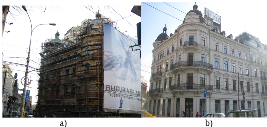
Fig. 4. Grand Hôtel du Boulevard : a) pendant la restauration (2011) ; b) après la restauration (2014)
