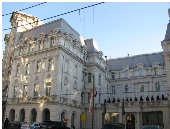
Fig. 2. Hôtel Continental après sa restauration (2011)
