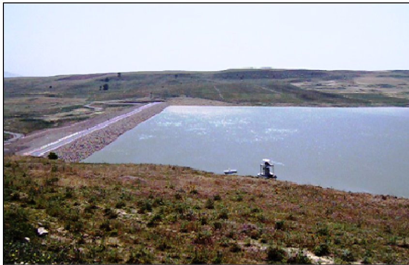
Photo 2. Digue en terre et lac du réservoir de Oued Athménia (photo A. Mebarki, 2008)
