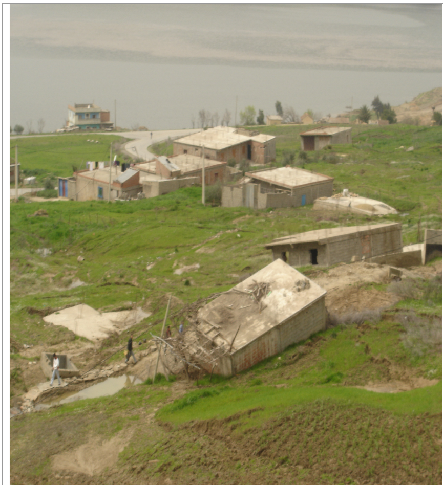
Photo 1. Glissements de terrains aux abords du barrage de Beni Haroun (village de Sibari) (photo A. Mebarki, 2005)
